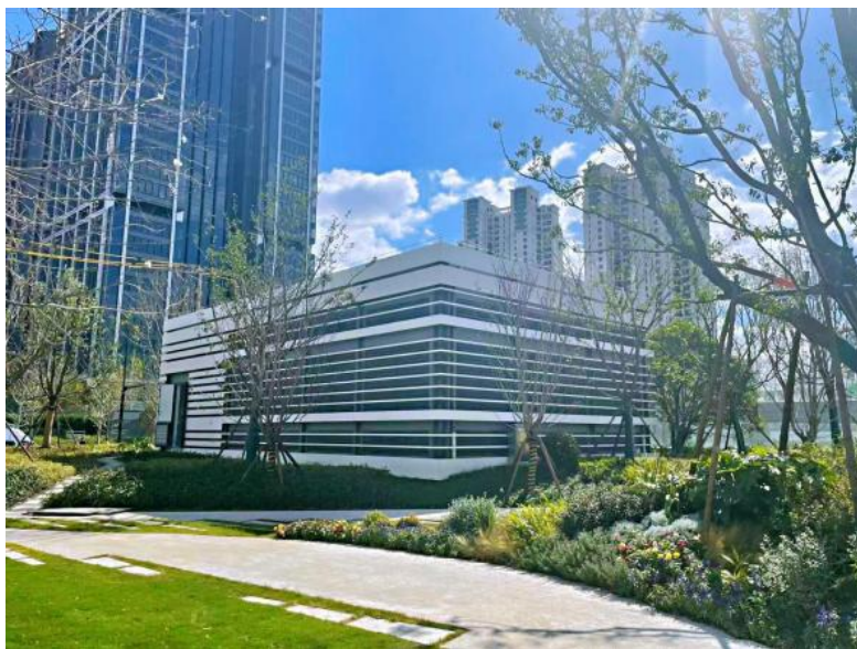
图 25-4 甘肃 110KV 变电站侧视图
