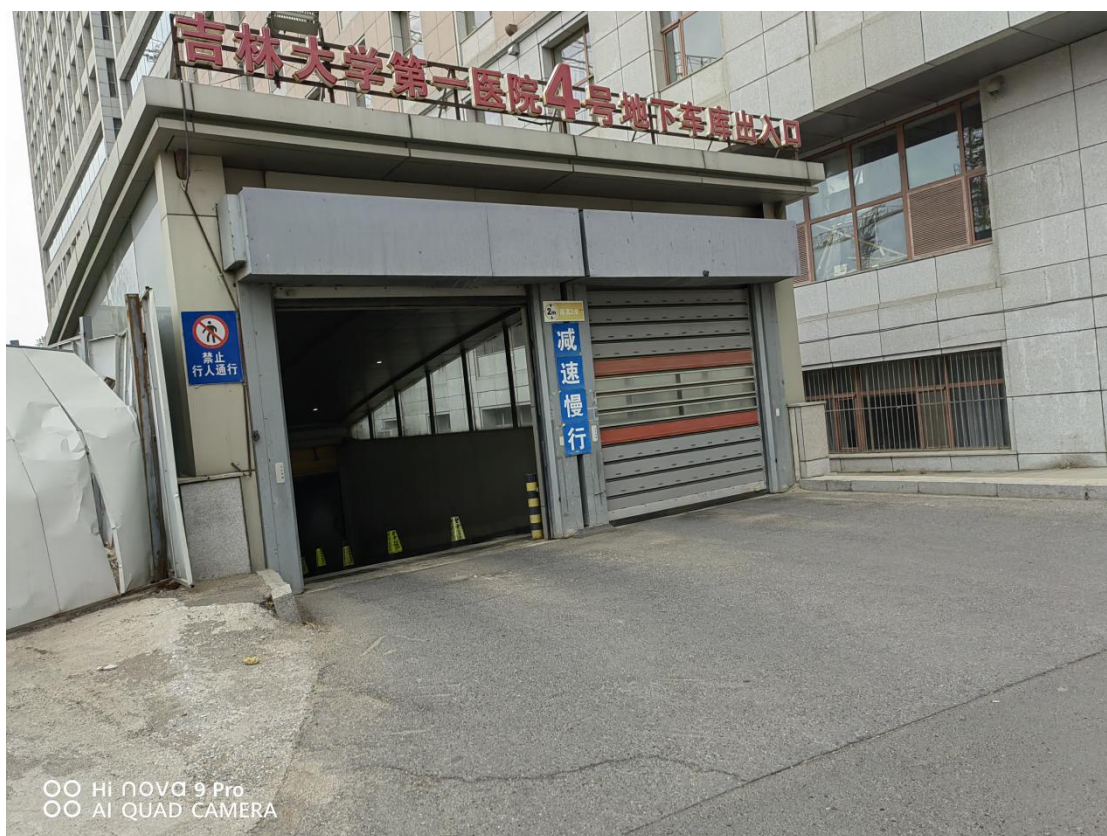
图 17-4 地下停车库出入口 1
