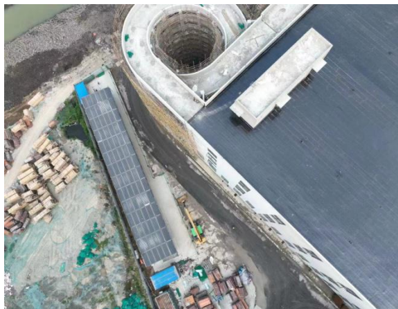
图 34-3 屋顶光伏现状图
