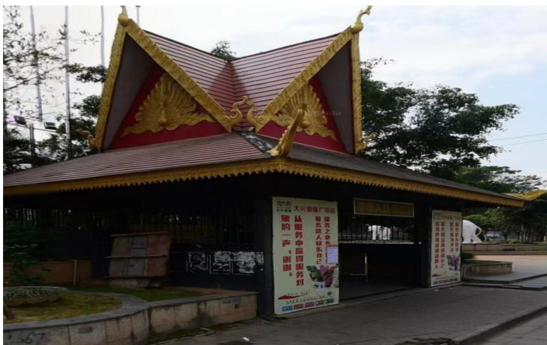
图 27-4 地下商场入口二
