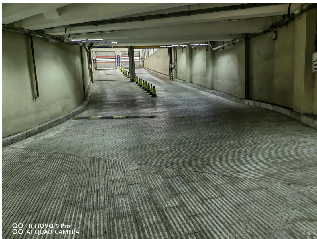
图 17-5 地下停车库出入口 2
