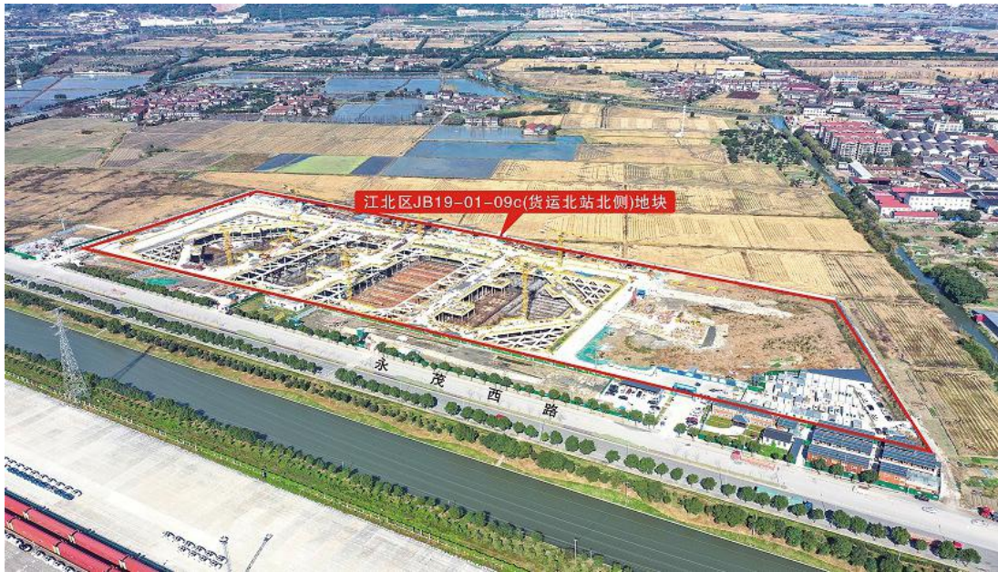
图 22-2 货运北站北侧地块地下水厂施工期间航拍图
