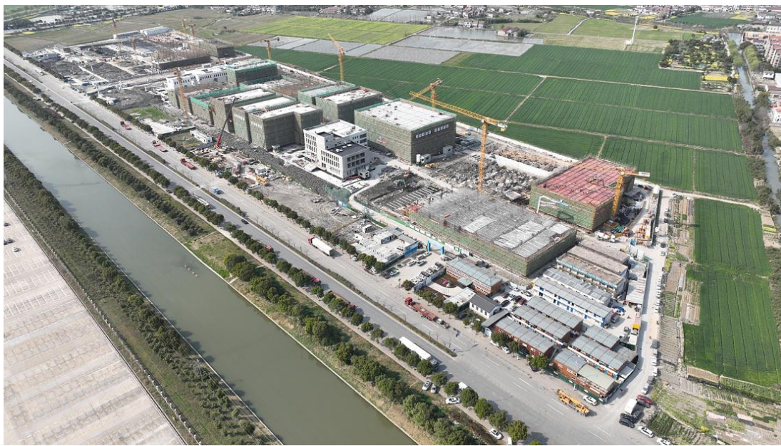
图 22-3 货运北站北侧地块地上项目施工期间航拍图
