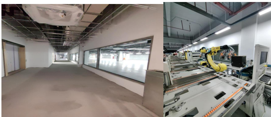
图 36-5 四楼设备精装区（实景图）
