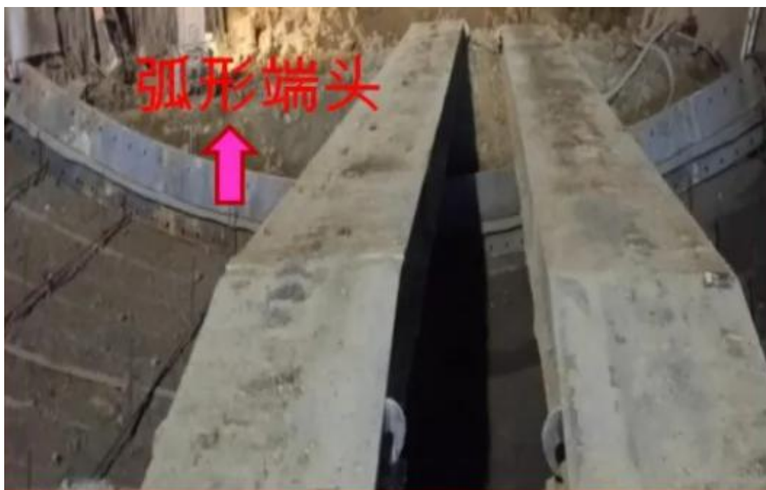
图 30-1 仰拱弧形端头模板
