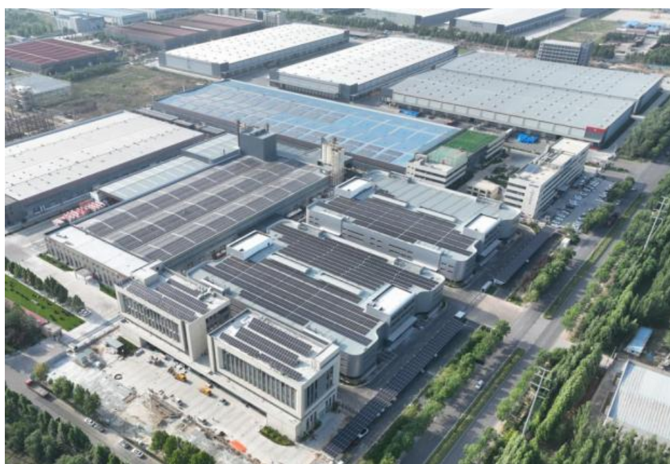
图 8-2 项目改造后建设状况
