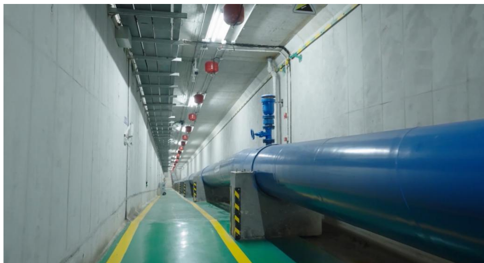
图 18-2 徐圩新区地下综合管廊一期
