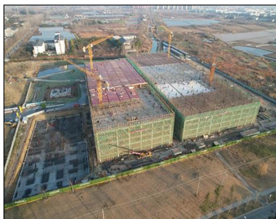
图 34-1 建设中施工现场图
