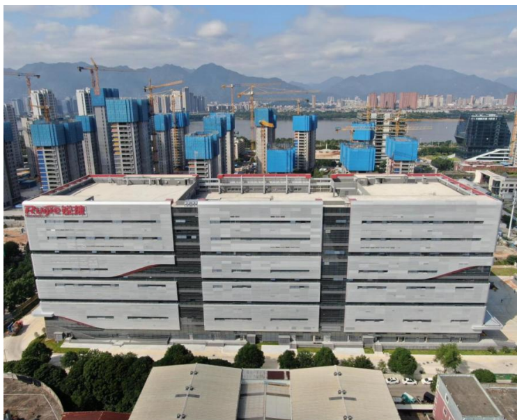
图 36-8 E 地块提升改造后实景图
