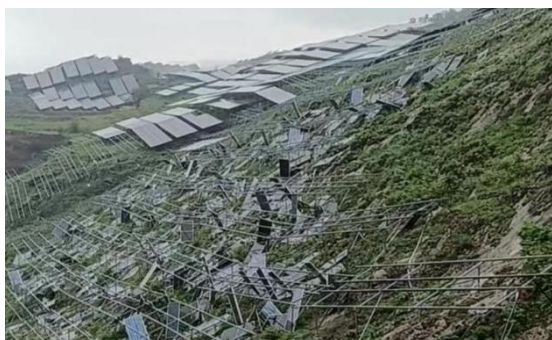
被大风损毁的光伏组件
