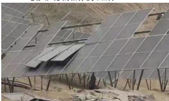
被大风损毁的光伏组件
