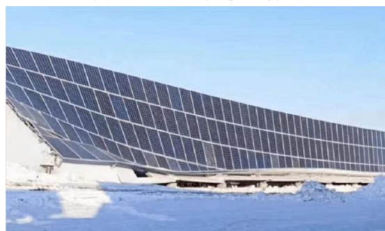
被大雪压毁的光伏组件
