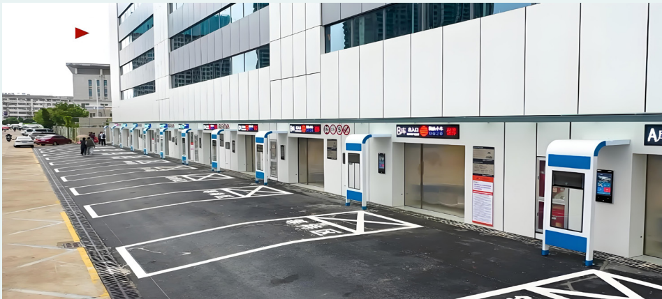
新建停车楼出入口
