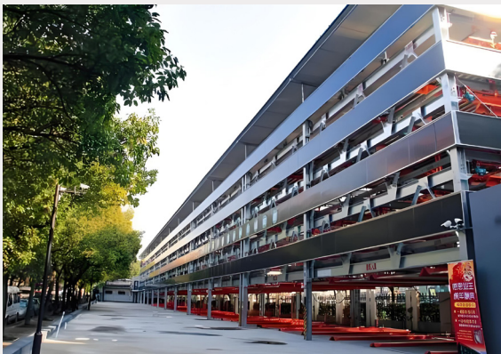
小区内立体化改造停车场
