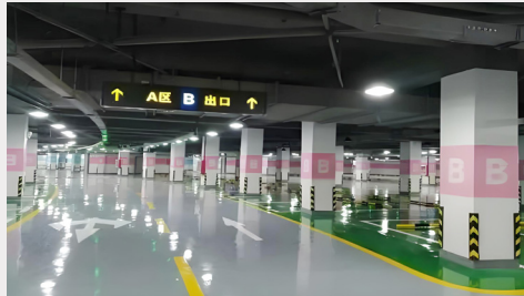
广场地下人防工程停车场
