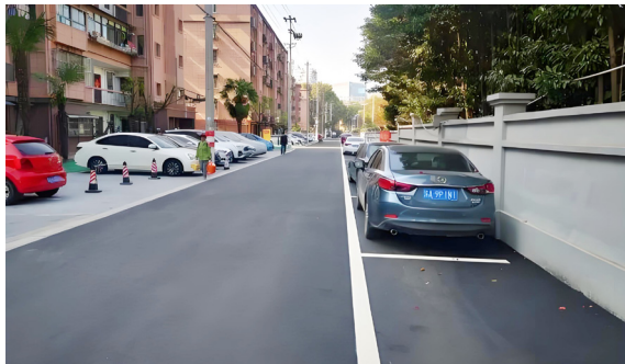
小区停车整治后实景图
