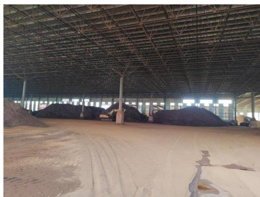
图 2.2-5 铁尾矿暂存库
