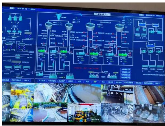
图 2.2-1 尾矿工艺流程及智能监控
