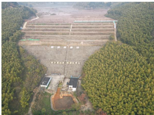
图 2.2-7 尾矿库全景图
