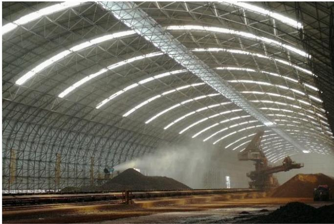
图 4-11 原料大棚内天雾及雾炮抑尘装置
