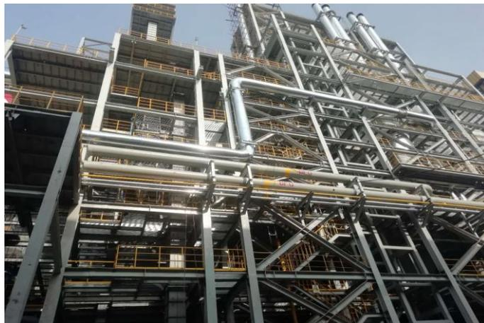
图 4-7 半干法脱硫+SCR 脱硝系统
