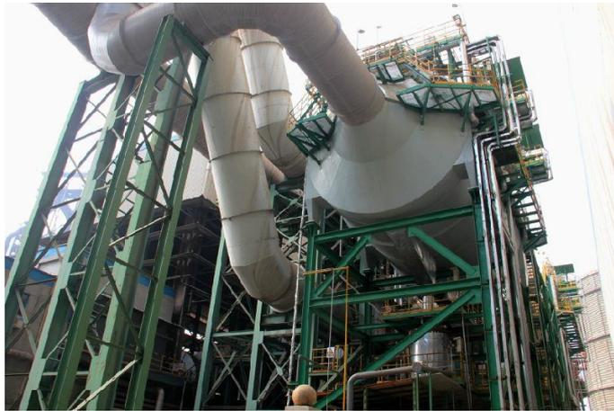
图 4-9 转炉一次 LT 干法除尘系统
