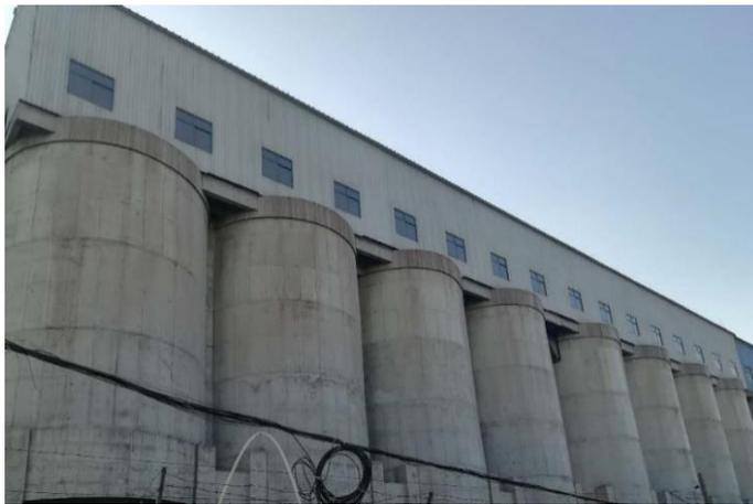
图 4-12 落地烧结矿筒仓
