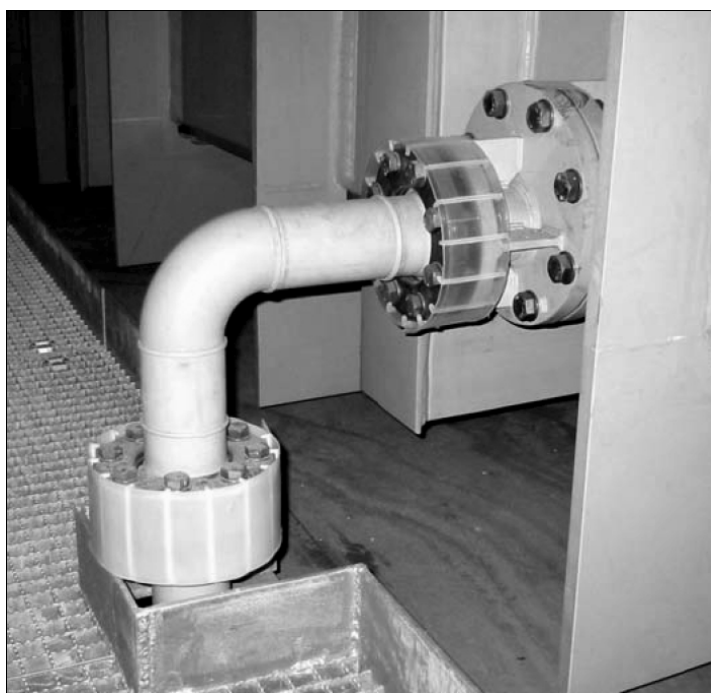
图 A.9 法兰盖示例
