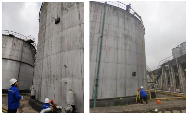
爬壁机器人油罐罐体测试
