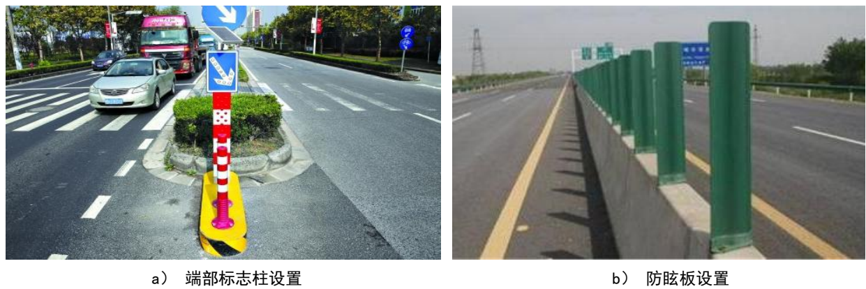
图 F. 39 中央隔离设施设置不当典型问题
