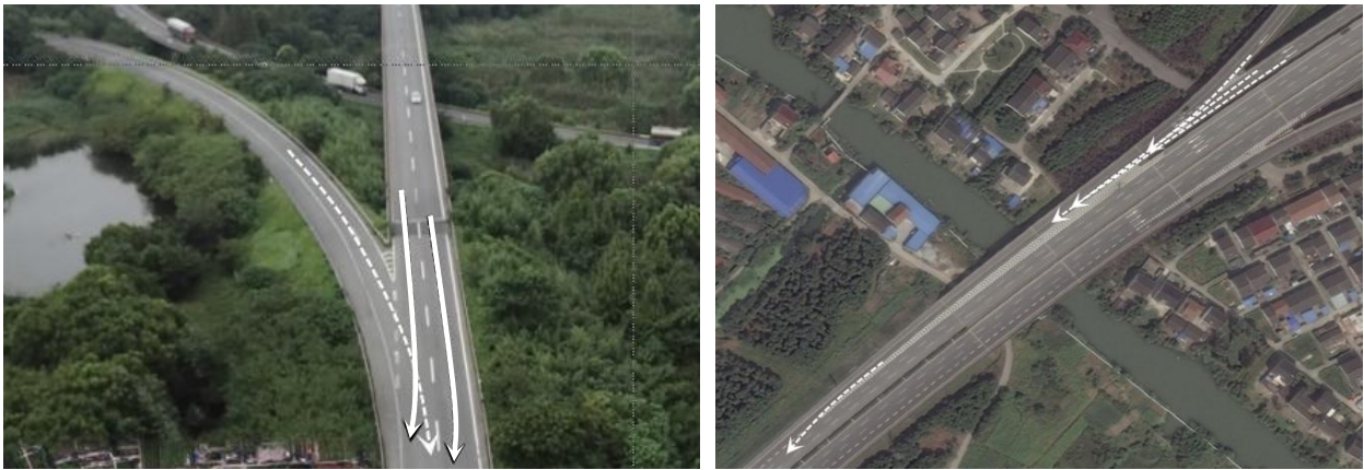
图 F. 30 立交合流段车道控制不当典型问题
