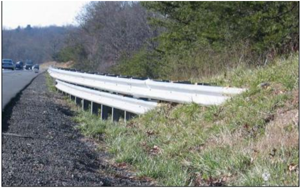
d) 护栏端部锚固处理
