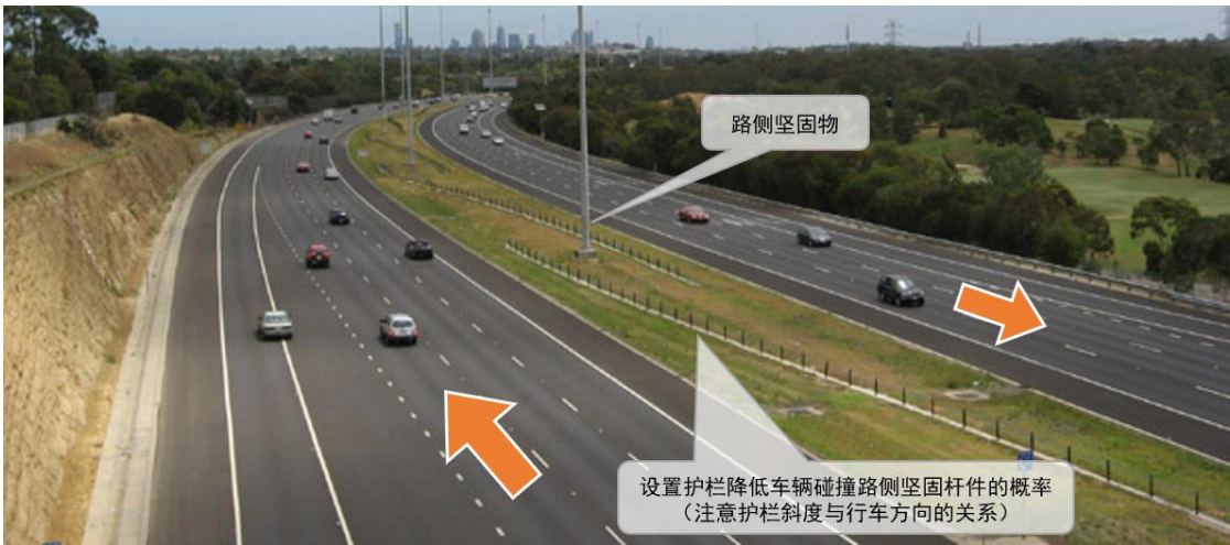
图 F. 45 路侧护栏与坚固物的示例（国外）
