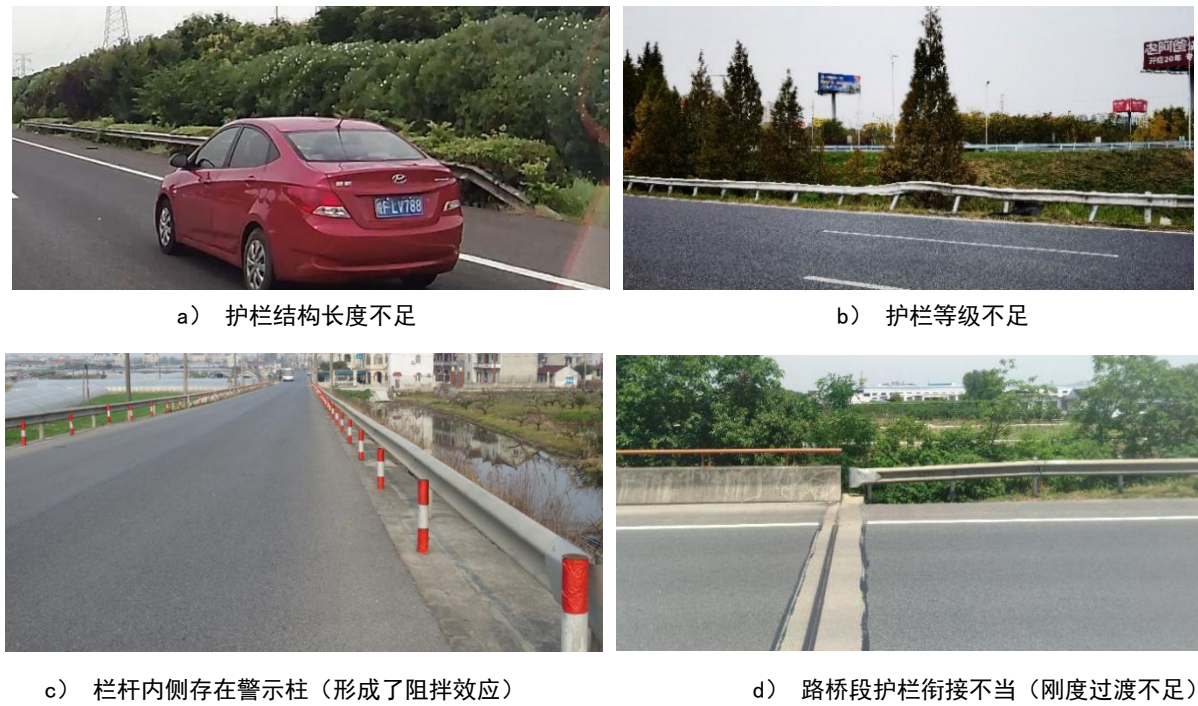
图 F.46 路侧防护设施设置不当典型问题
