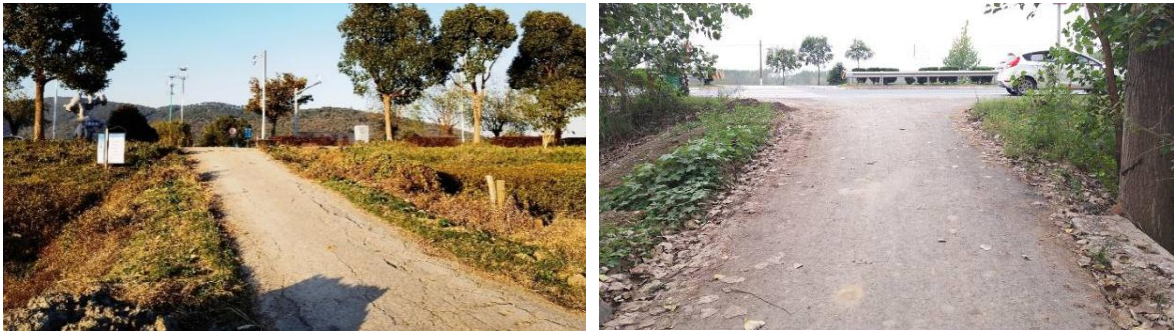
图 F. 37 接入口陡坡典型问题
