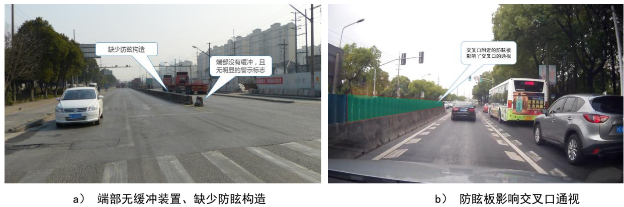
图 F. 39 中央隔离设施设置不当典型问题
