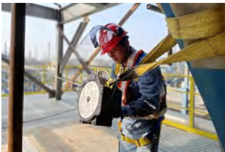
张阳在检查高处作业防护设施
