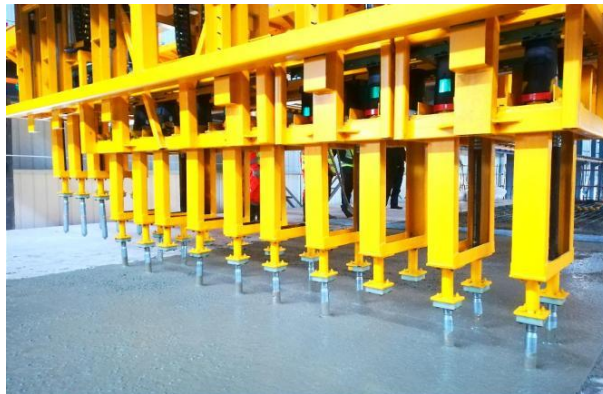
图 D.8 排振机实物示意图
