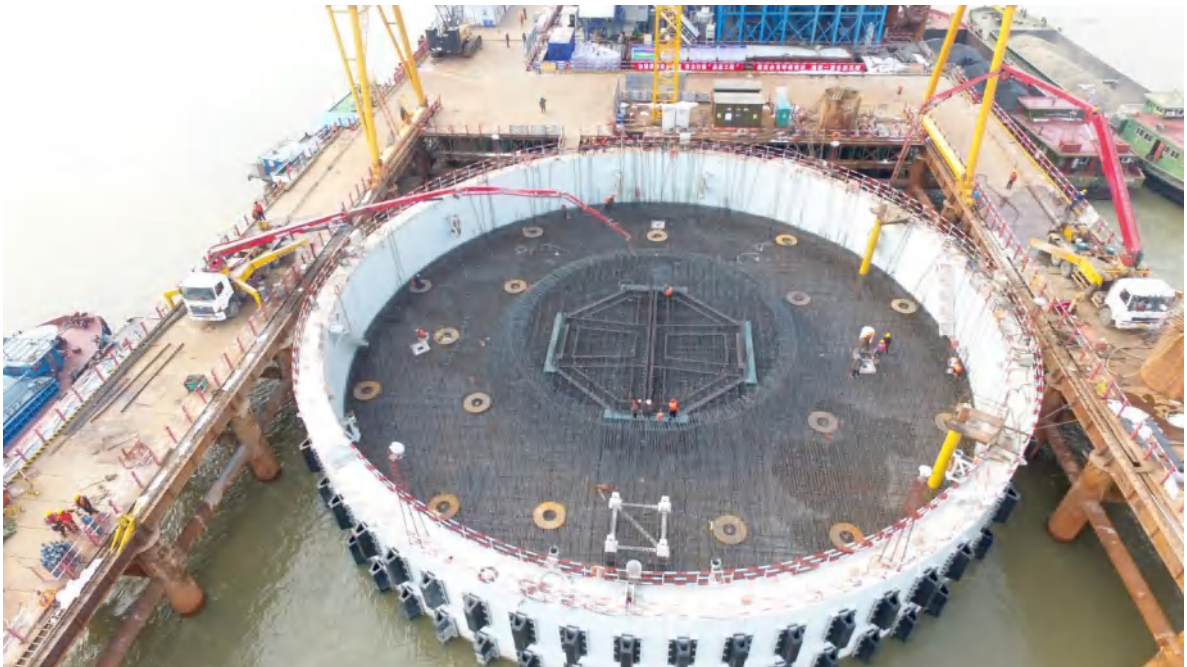
图 2 主墩承台施工
