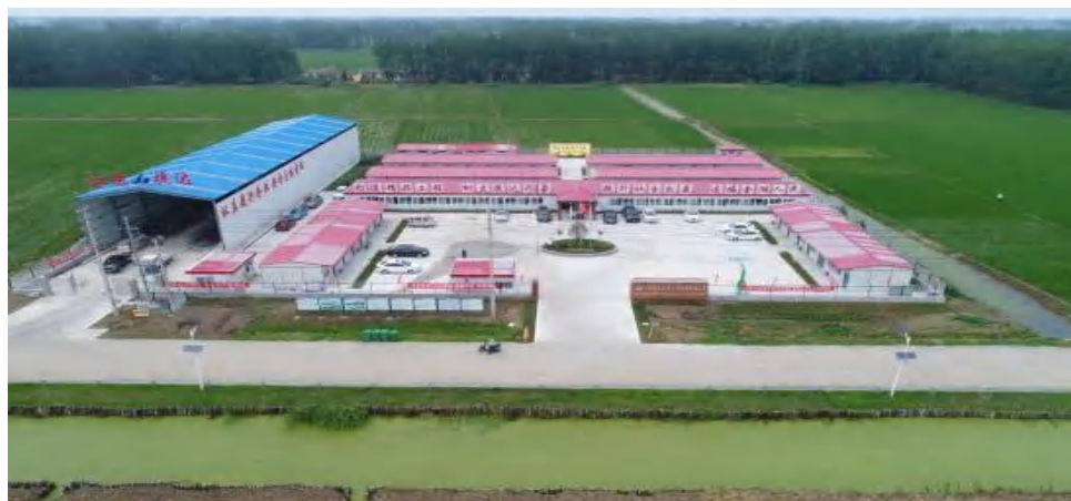
项目部办公、生活区及钢筋加工场
