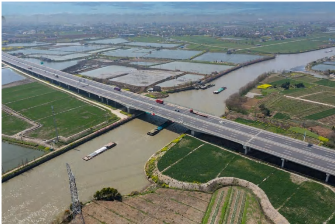
锡溧漕河特大桥
