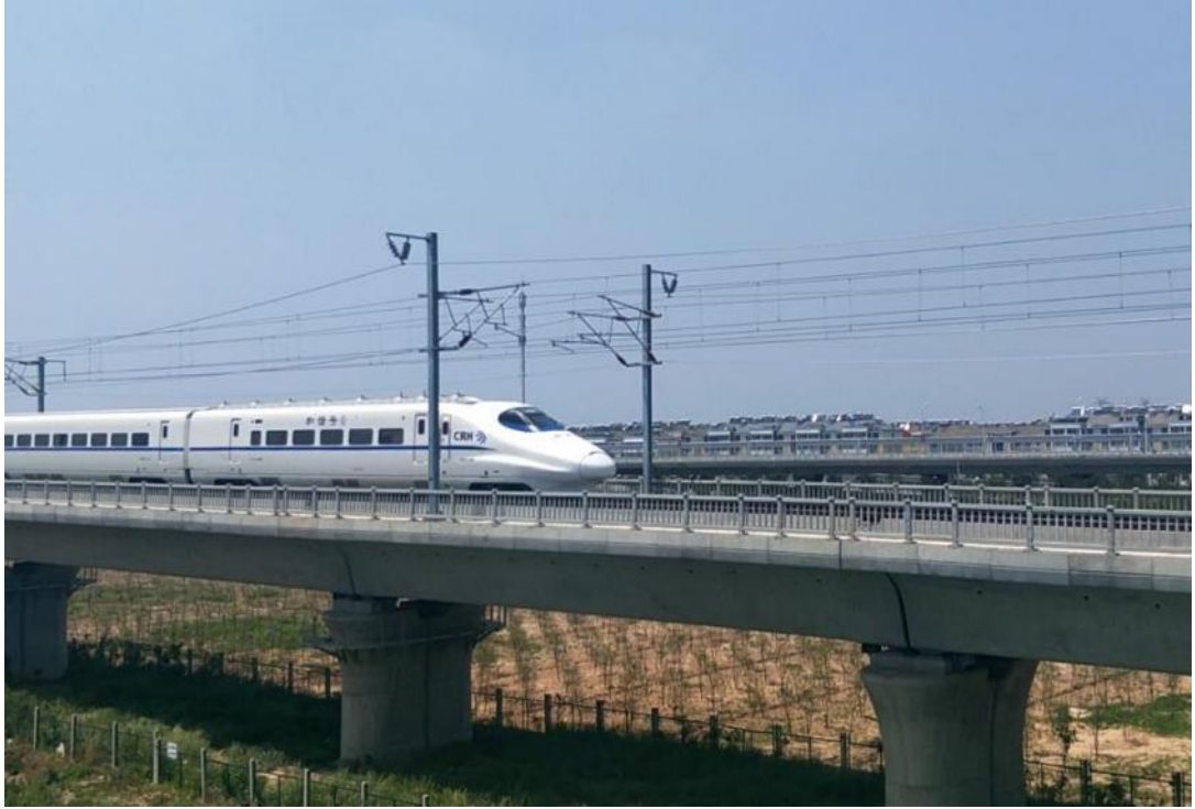
徐洪河特大桥通车运营
