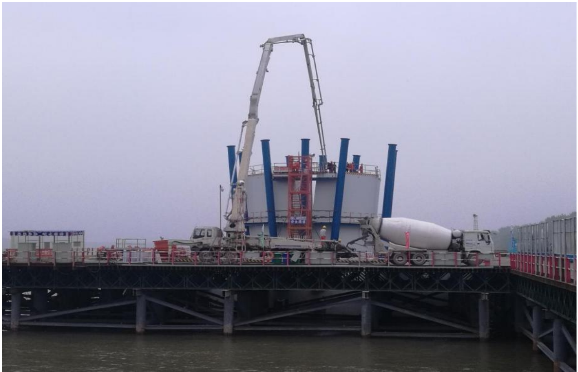
图 4 索塔混凝土浇筑
