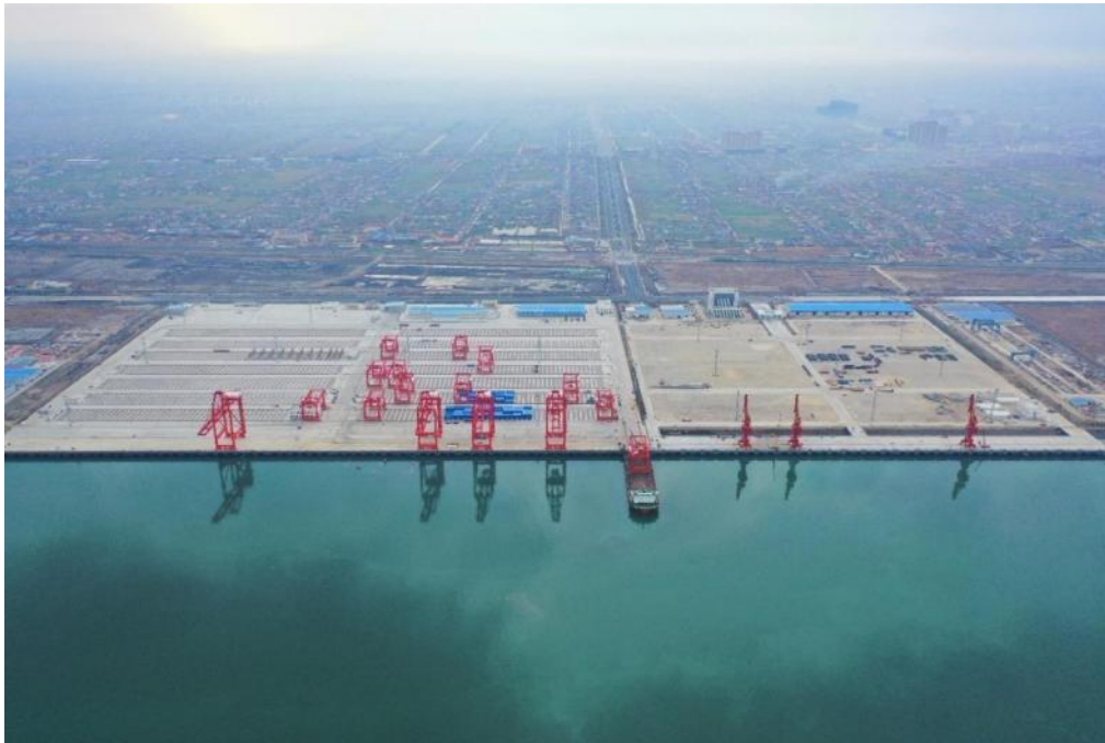
南通港吕四作业区西港池 8#-11#码头工程全景航拍图（试运行）
