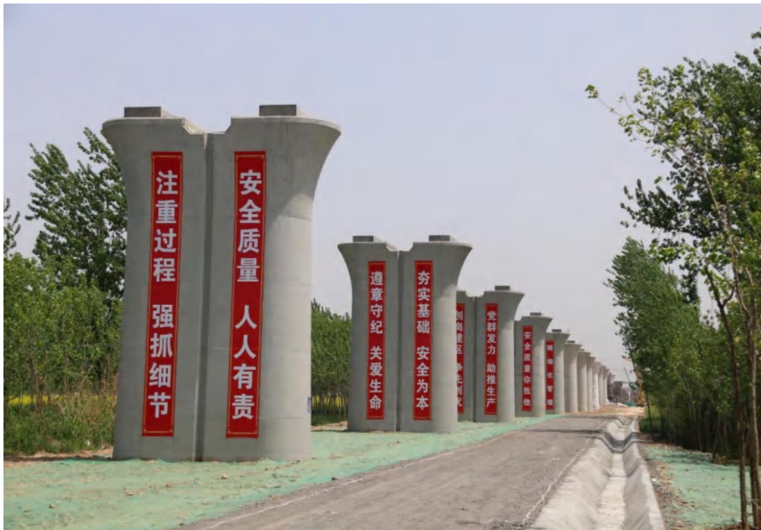
徐洪河特大桥墩身
