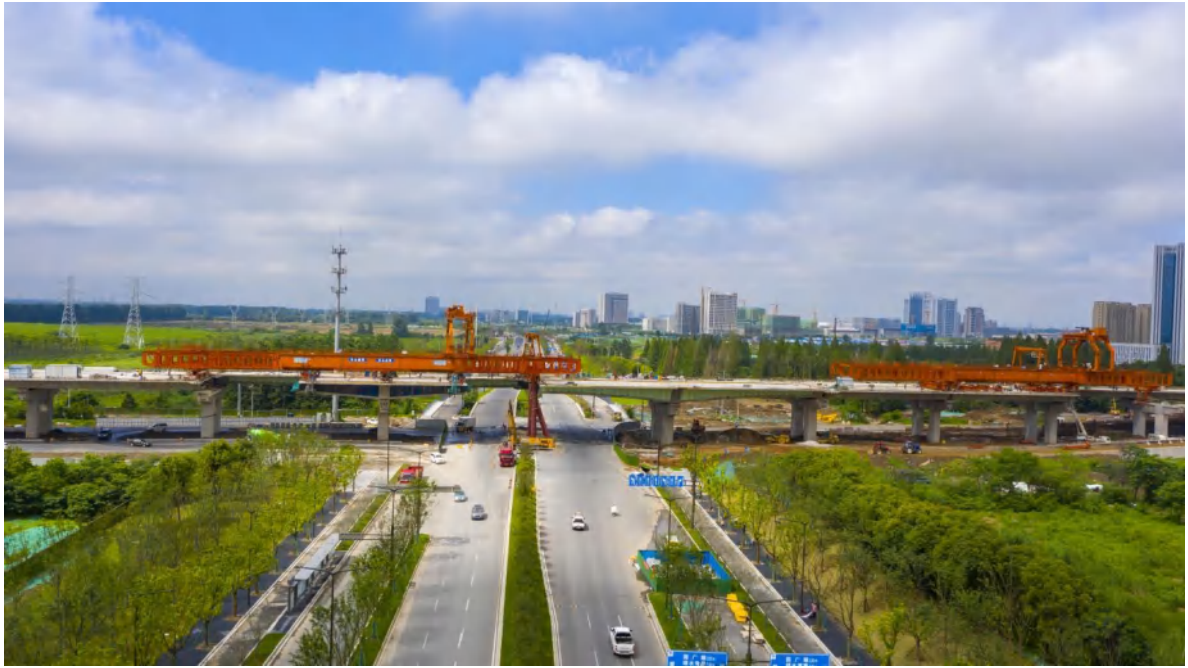
图 7 波形钢腹板节段梁安装
