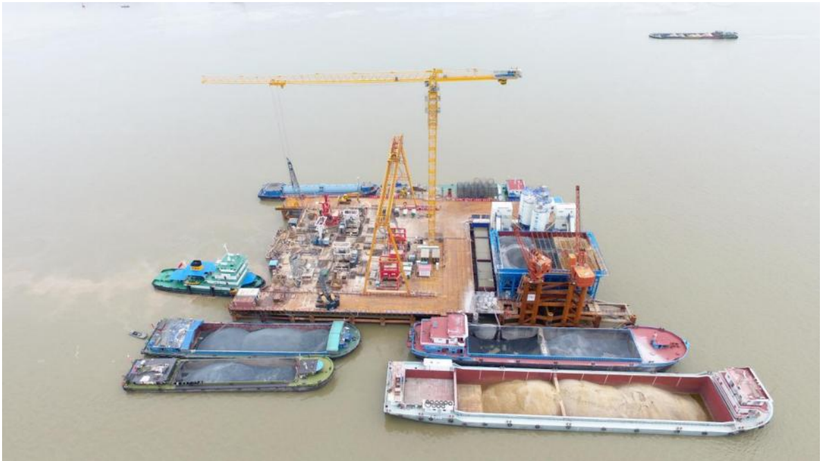
图 1 钻孔桩施工
