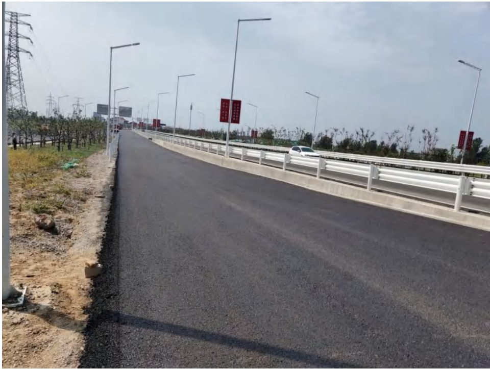
匝道面层施工图片
