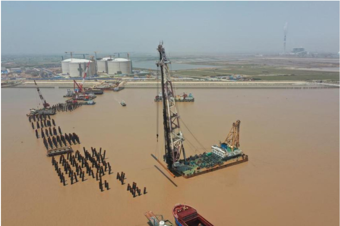
LNG 码头靠船墩 3-15#钢管桩沉桩
