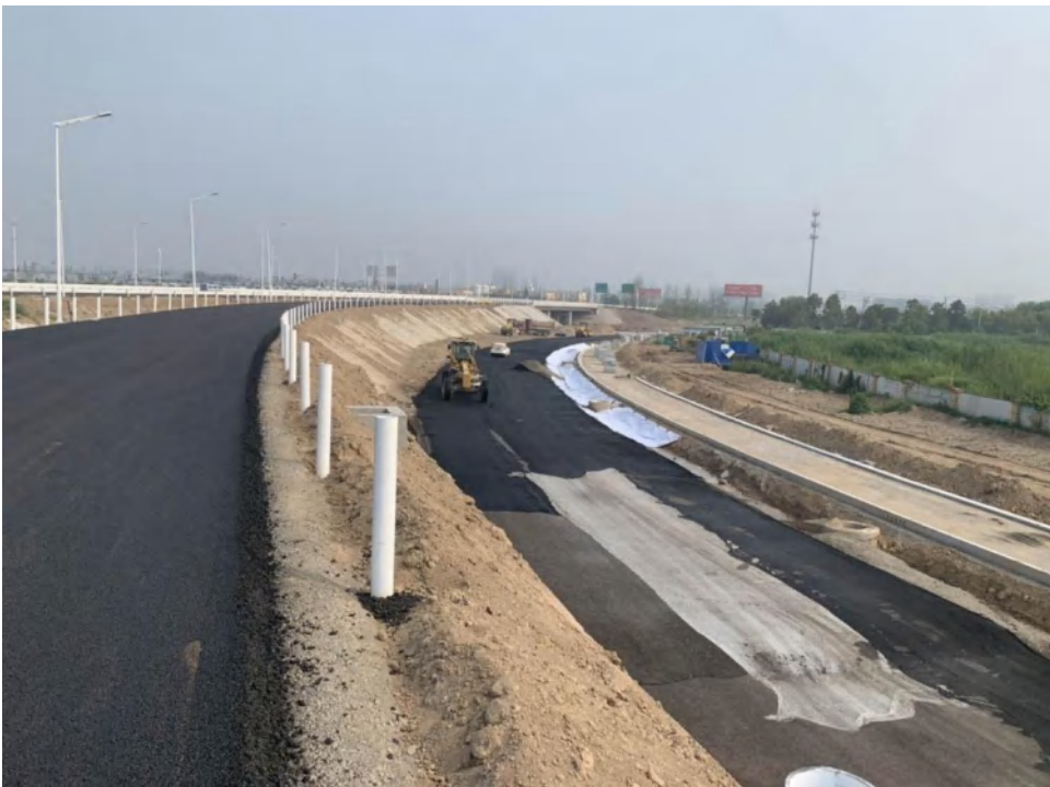
互通水稳、沥青施工图片
