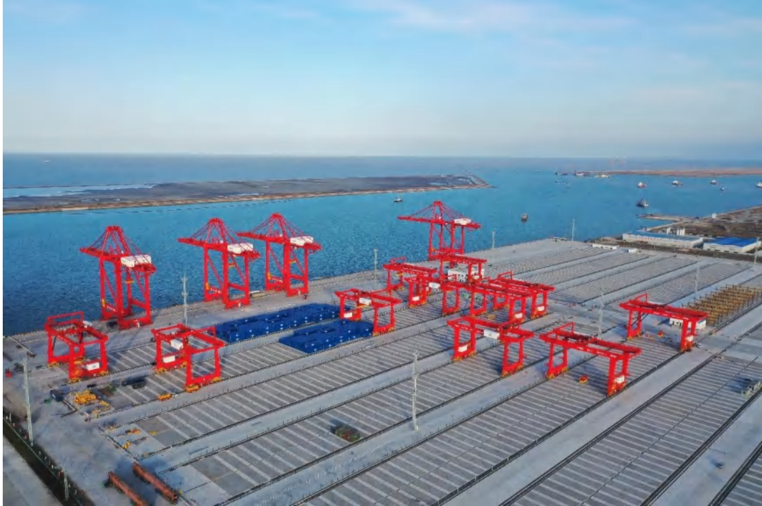
5G 自动化岸桥和集装箱堆场
