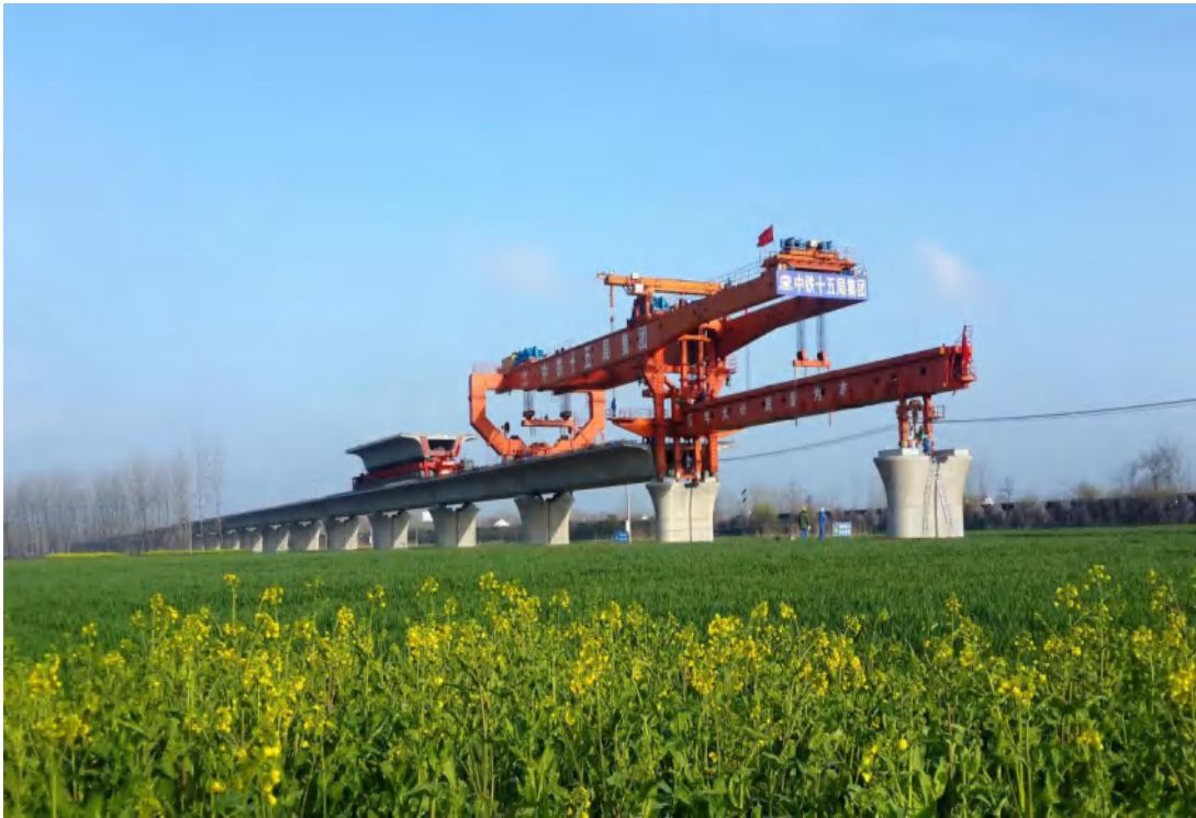
徐洪河特大桥架梁
