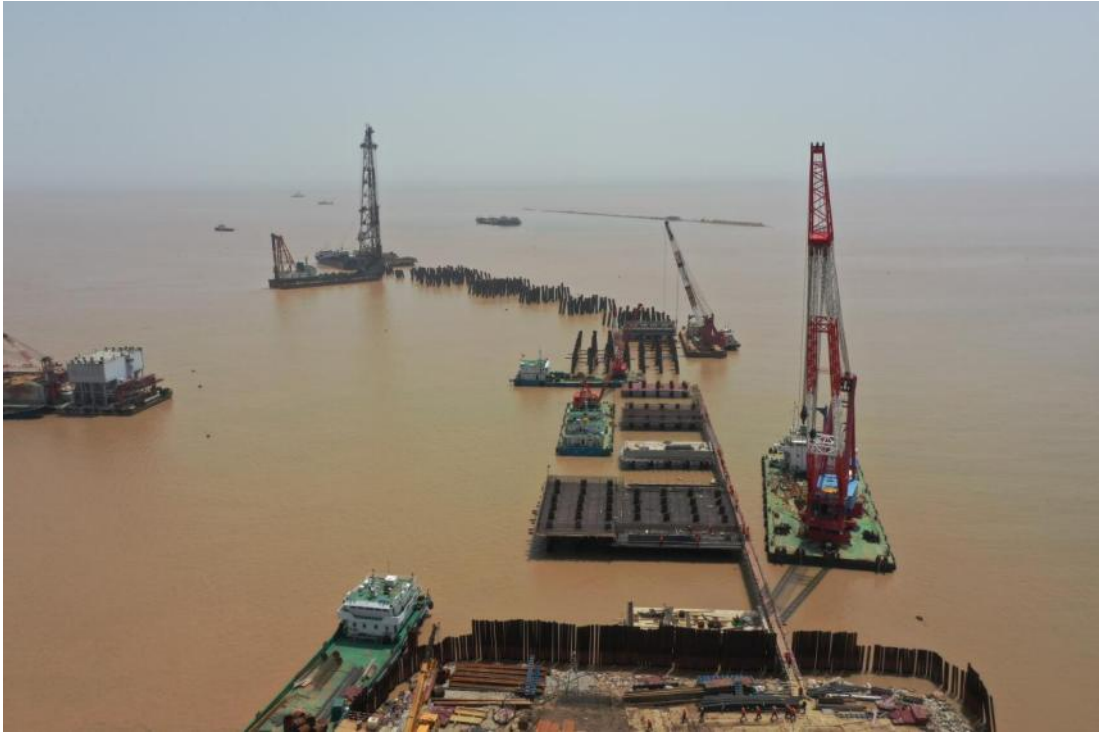
LNG 码头靠船墩 3-15#钢管桩沉桩
