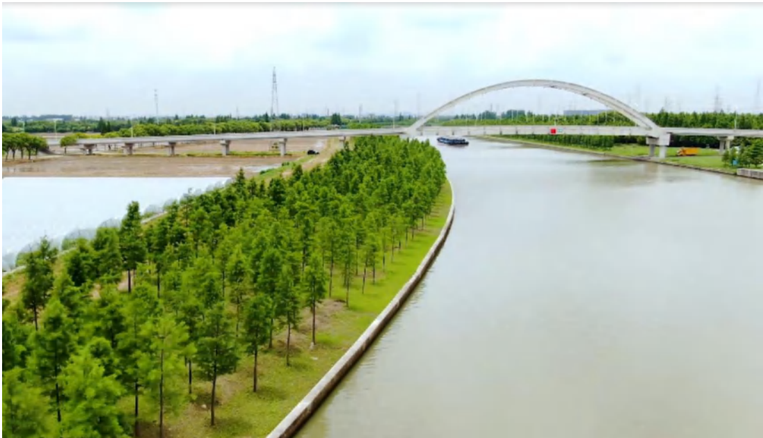
杨林塘航道太仓段主航道及桥梁
