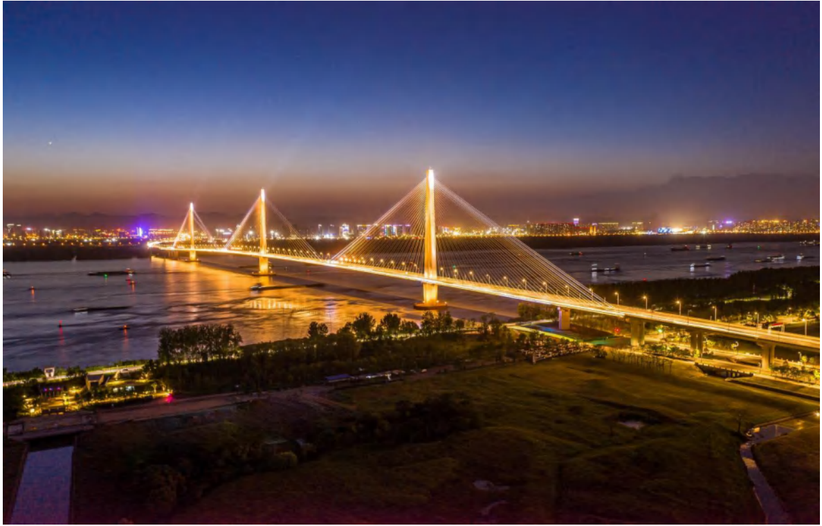
图 10 工程全貌（夜景）
