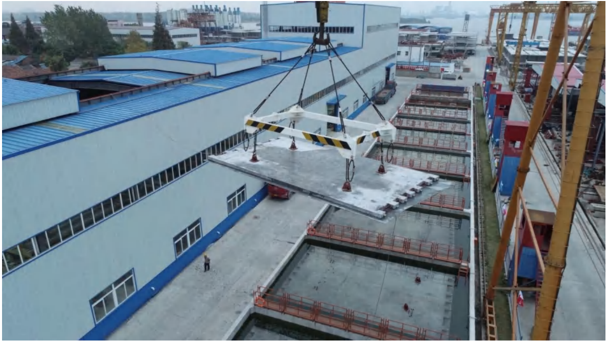
图 5 UHPC 桥面板预制
