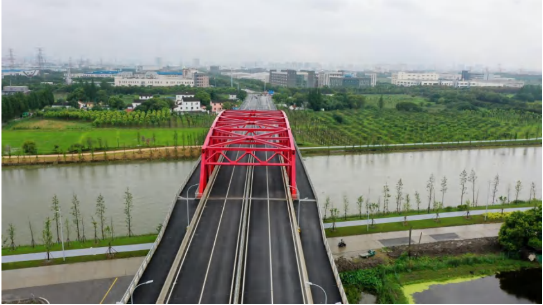
昆山段航道上桥梁
