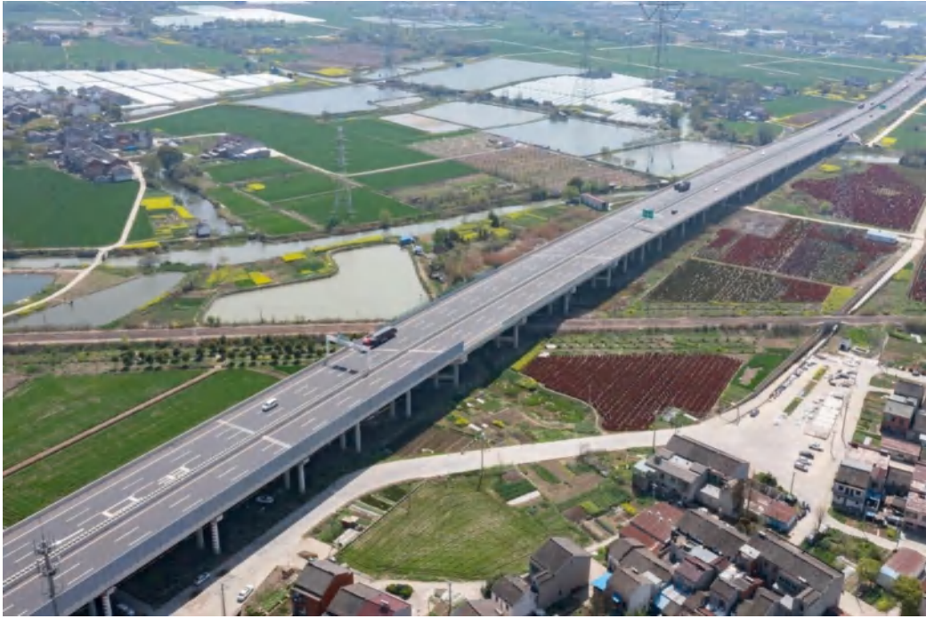
新长铁路特大桥
