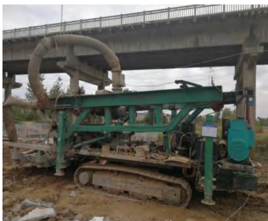
液压反循环钻机施工
