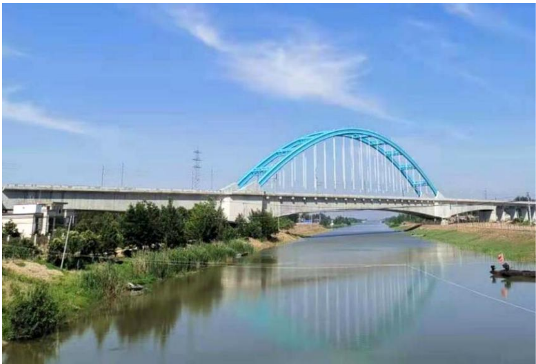
徐洪河特大桥 200 米连续梁拱
