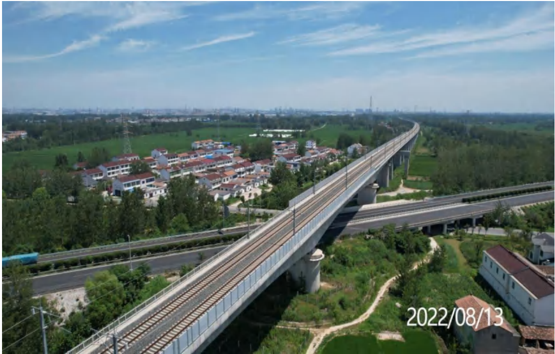
徐洪河特大桥跨高速公路连续梁
