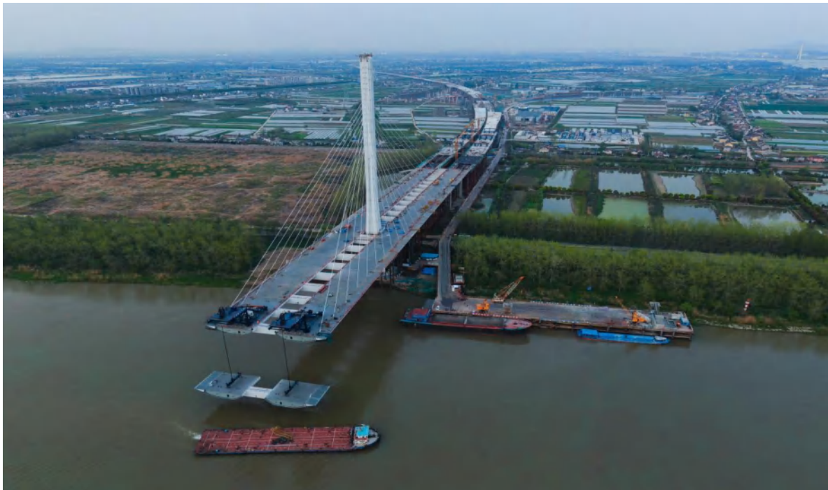
主桥分幅式钢箱梁吊装
