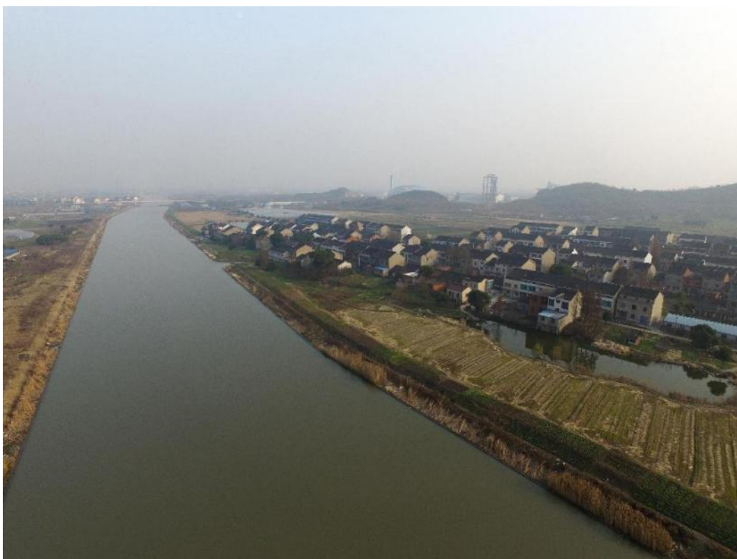
整治后的航道
