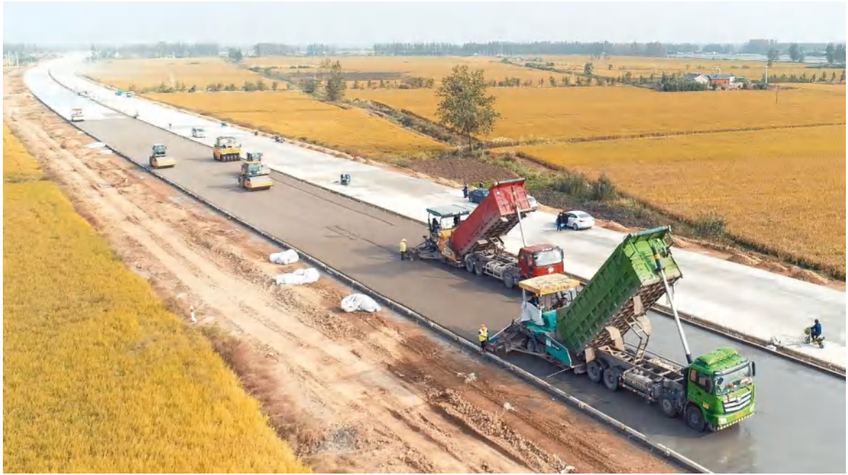
水稳基层施工
