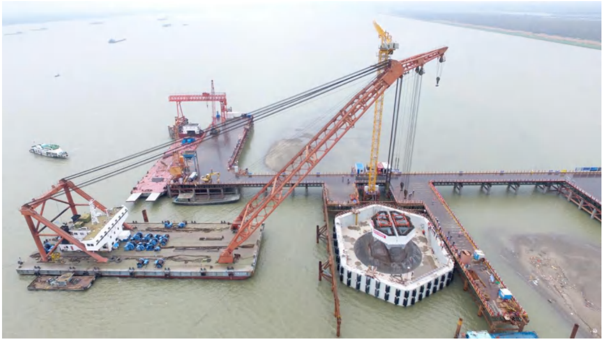
图 3 索塔钢壳吊装
