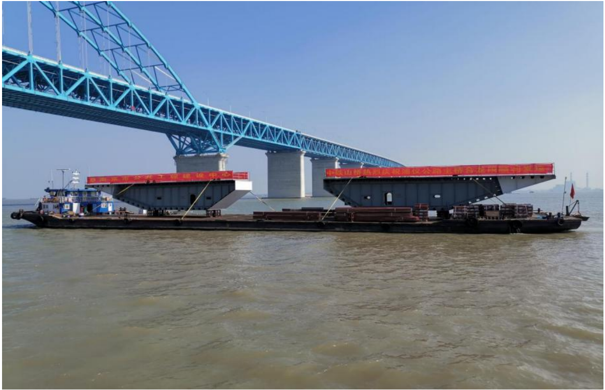
主桥分幅式钢箱梁运输
