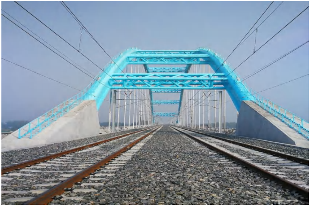
徐洪河特大桥 200 米连续梁拱
