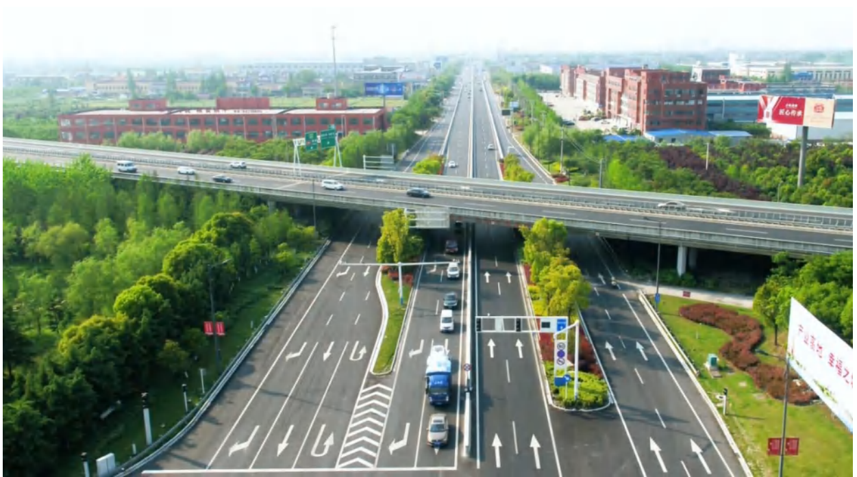
项目建成总体实景图
