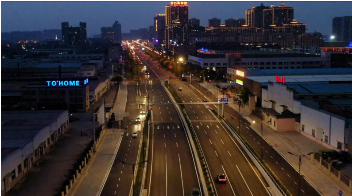
项目建成总体夜景图
