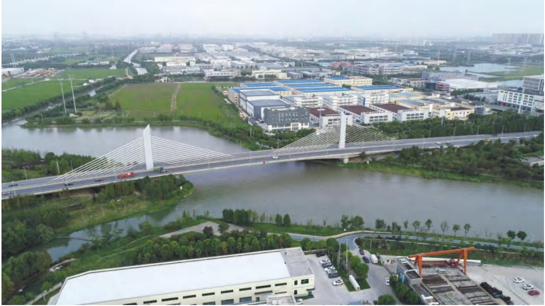
金鸡河吴塘河段上桥梁
