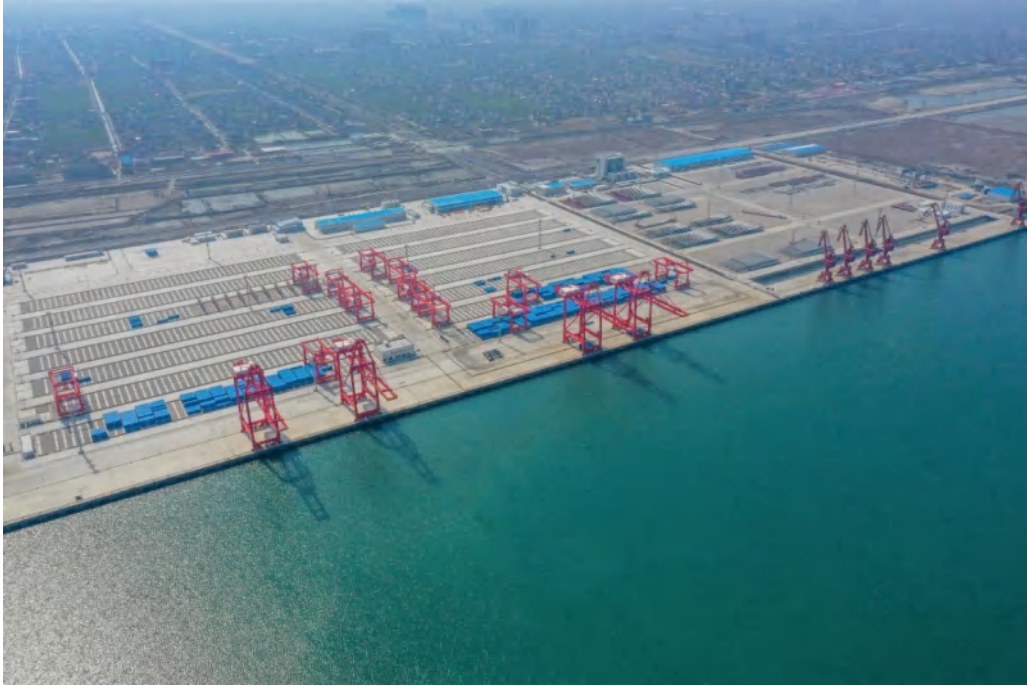
南通港吕四作业区西港池 8#-11#码头工程全景航拍图（运营）
