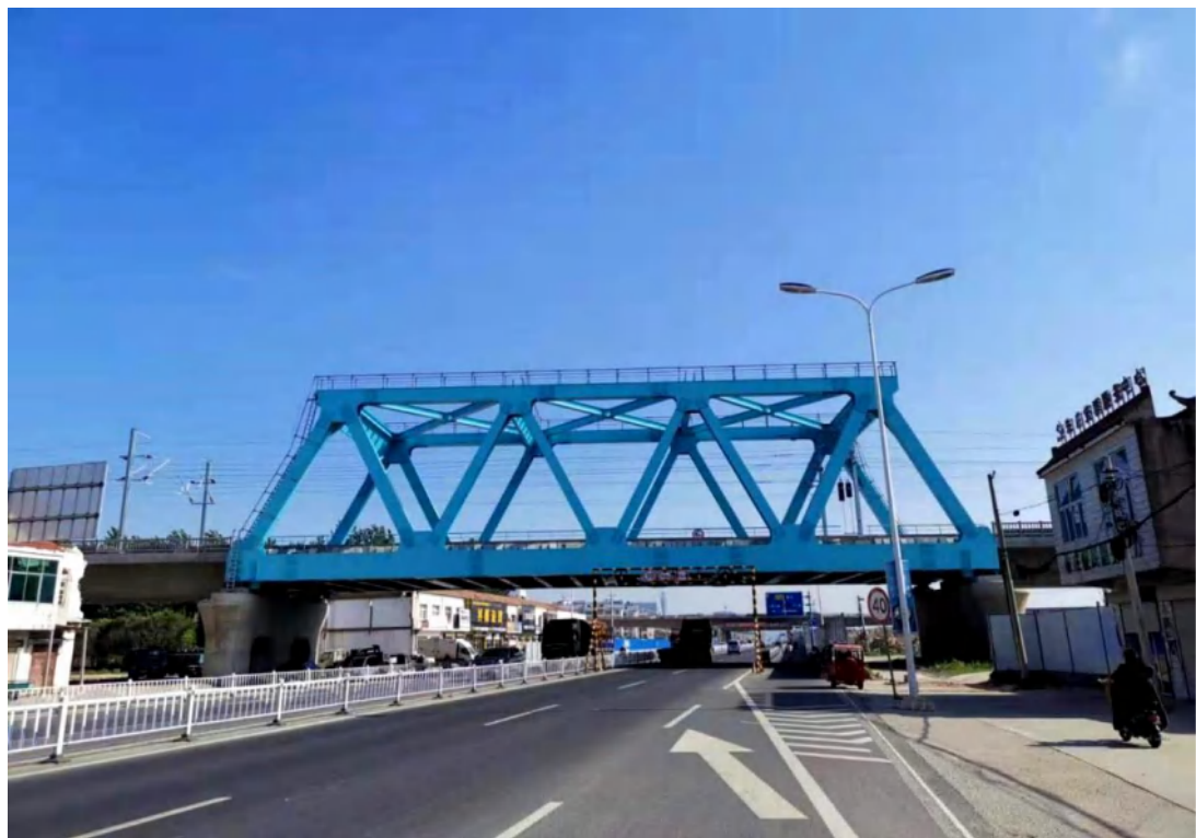
徐洪河特大桥钢桁梁
