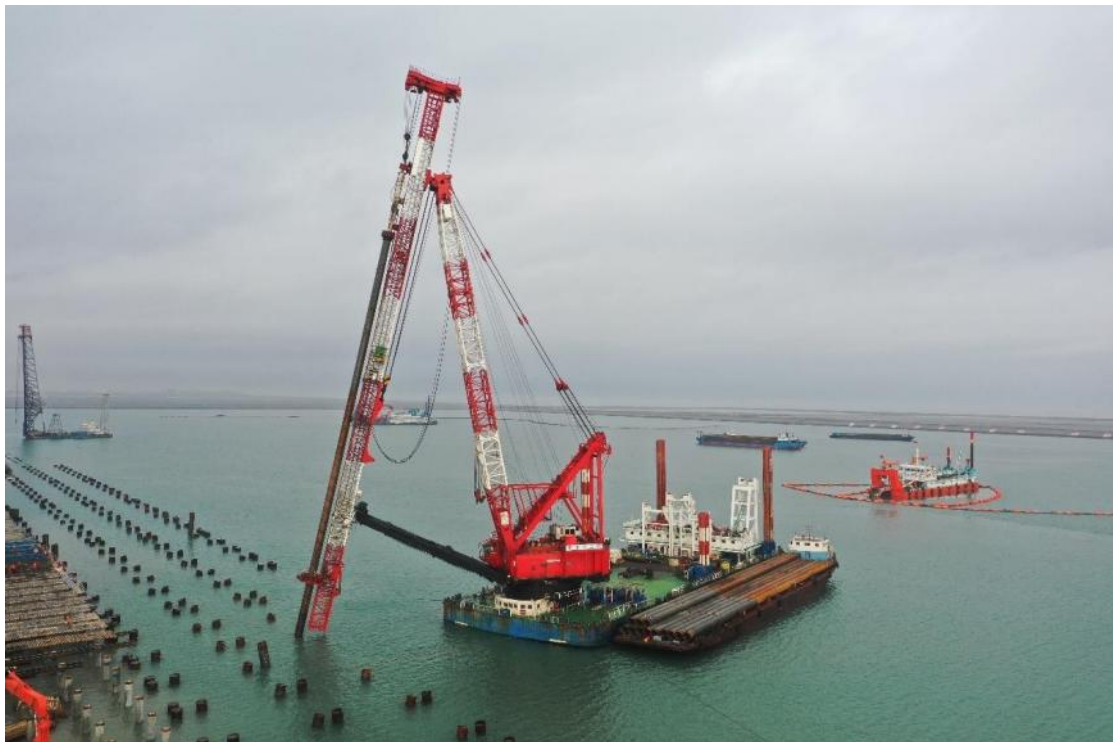
宁波海力 801 打桩船水上沉桩
