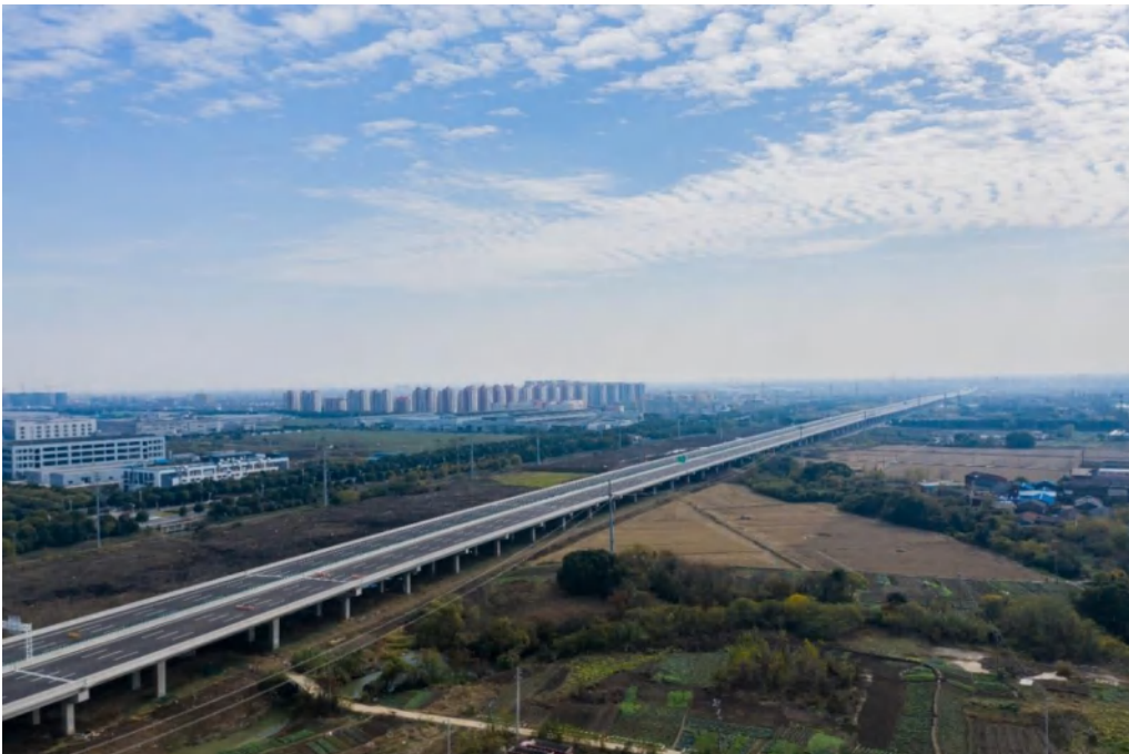
武进高新区高架桥
