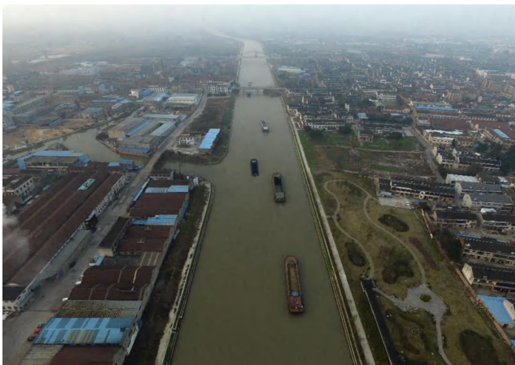
整治后的航道
