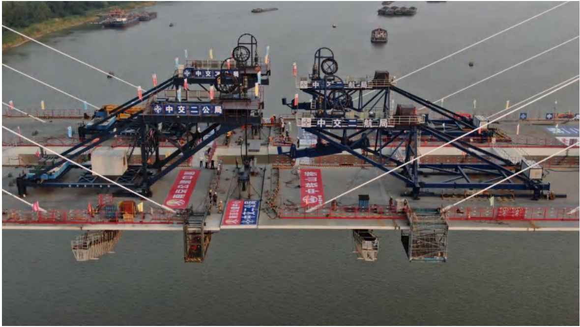
主桥钢箱梁合龙
