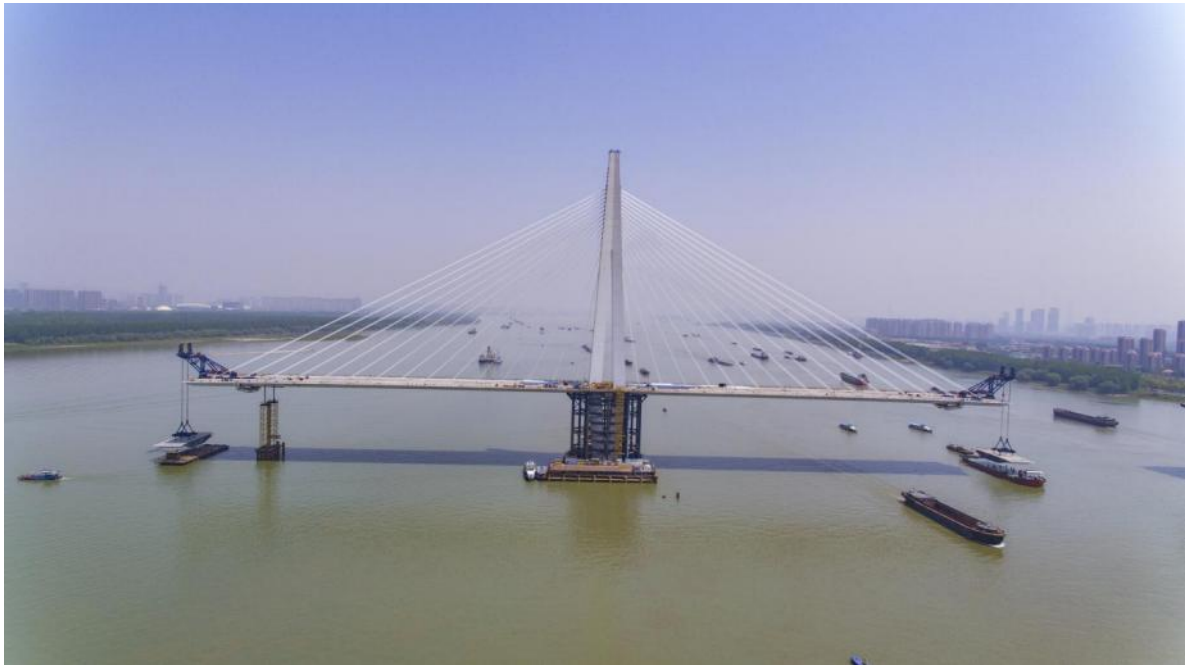
图 6 钢混组合梁吊装
