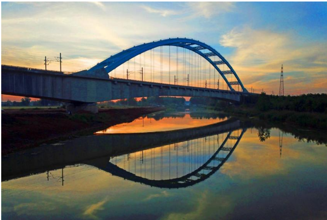
徐洪河特大桥200米连续梁拱
