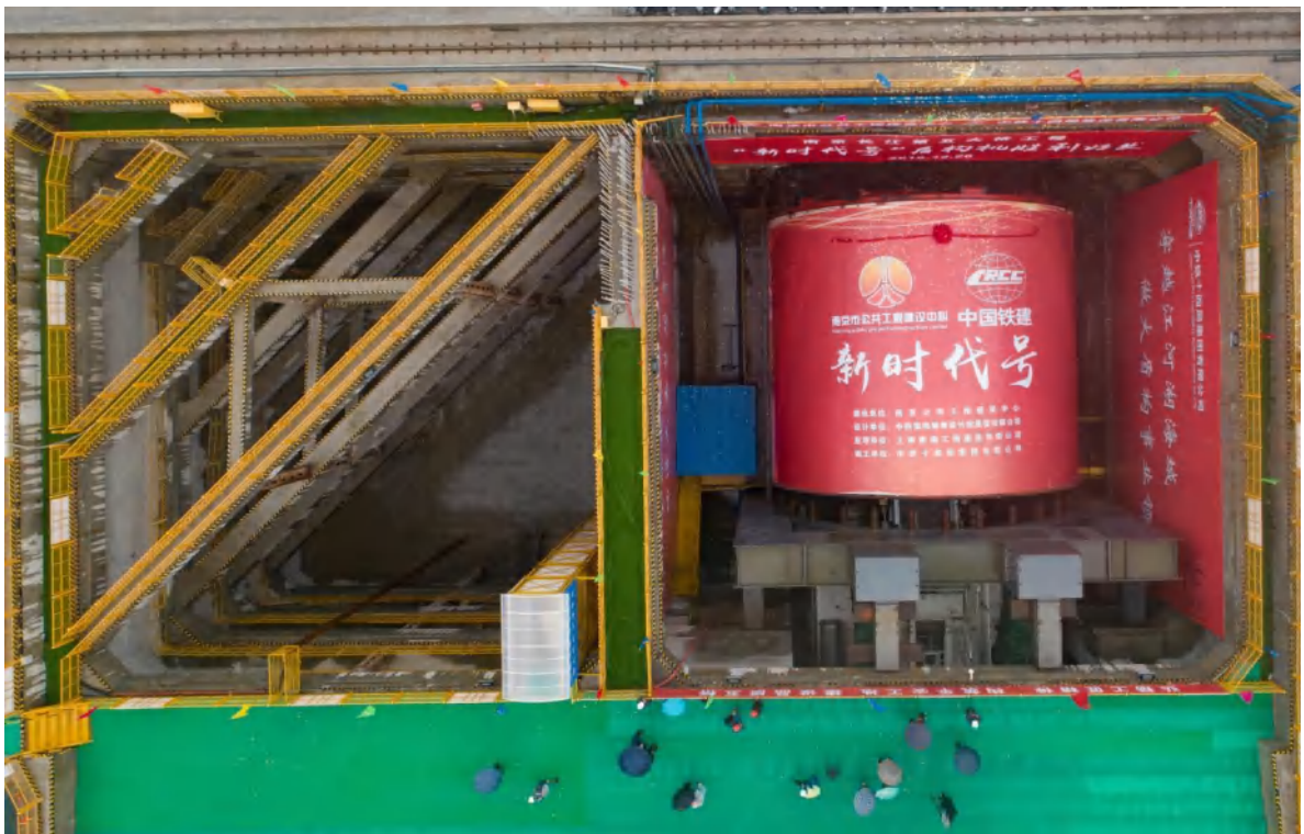
图 8 夹江隧道盾构始发
